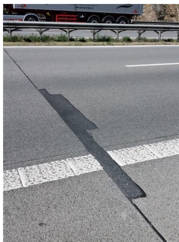
Stav po provedení opravy
