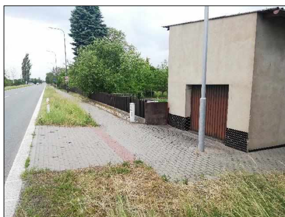
Po realizaci projektu – konec úseku II
