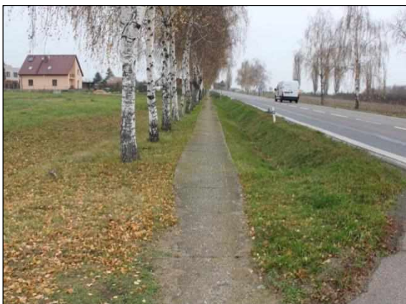
Před realizací projektu – začátek úseku I
