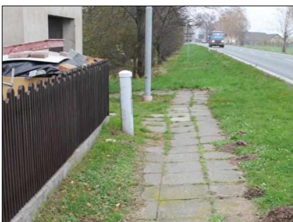
Před realizací projektu – konec úseku II
