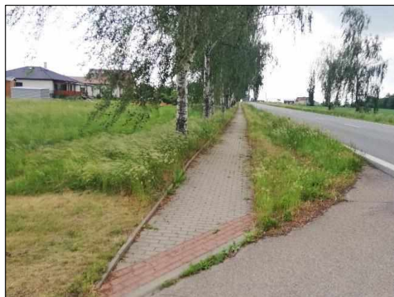
Po realizaci projektu – začátek úseku I
