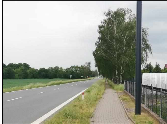
Úsek I – pohled západním směrem
