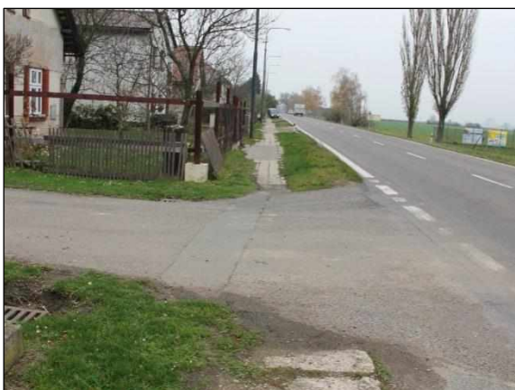
Před realizací projektu – začátek úseku II
