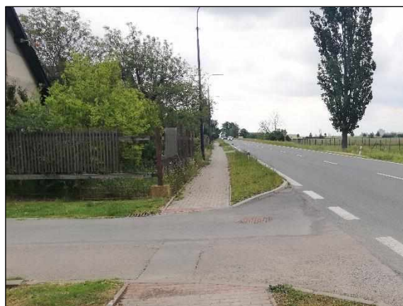
Po realizaci projektu – začátek úseku II
