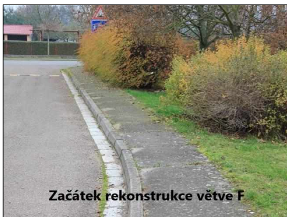
Před realizací projektu
