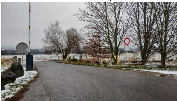
Obrázek č. 5: D1 Kalná km 58,2 vlevo
